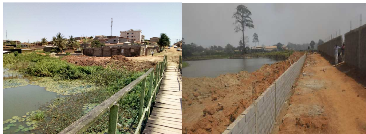
Photo 13 à 14: Remblai de construction au bord du lac au quartier Sonouko-Manzan
