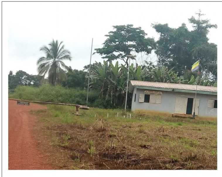
Fig. 2 : Le bâtiment de la gendarmerie et le poste-frontière à Lékindo
