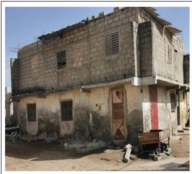
Fig. 8 : Adaptation d'une maison de type B transformée en type C pour faire face aux inondations (Seck ,2024)
