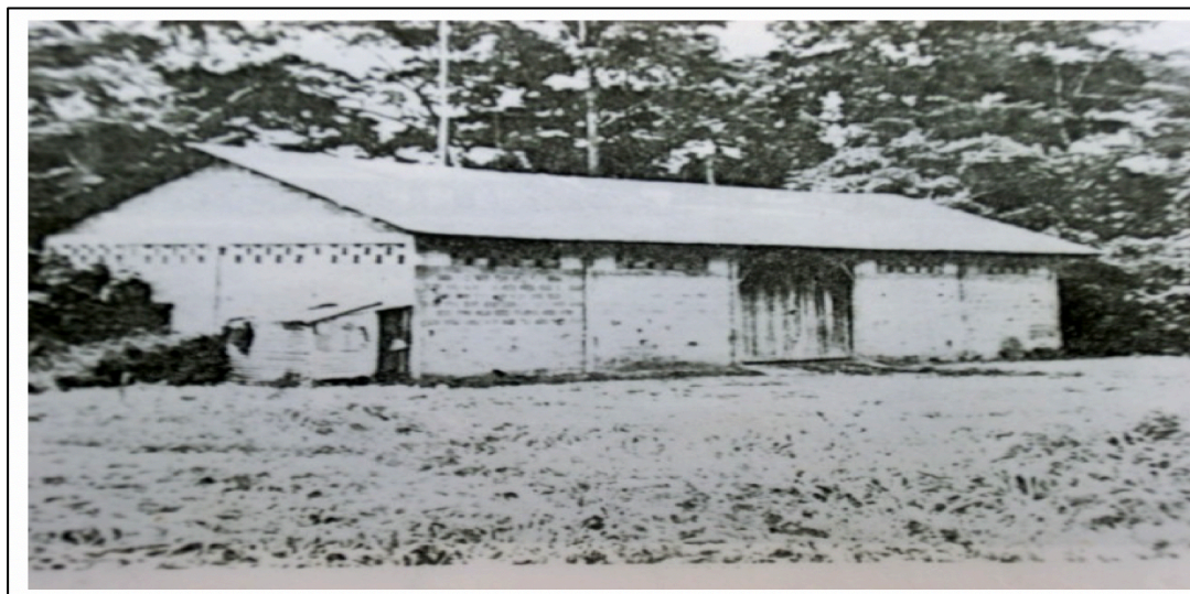
Fig. 1 : Magasin de la section coopérative de Mvangan (1985)
