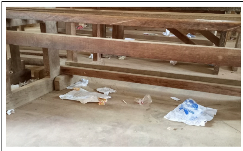
Fig. 2 : Rejet des déchets à l'intérieur des salles de classes par les élèves
