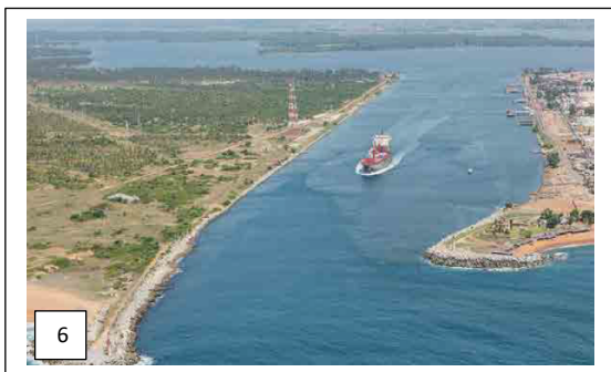
Fig. 6. Configuration du canal de Vridi avant les travaux
