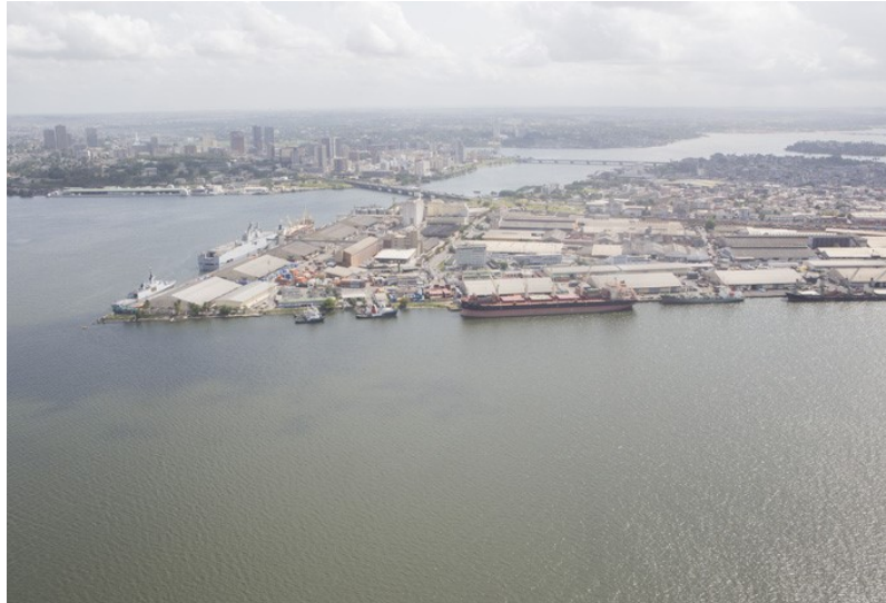
Fig. 12. Le port d'Abidjan avant la construction du terminal céréalier
