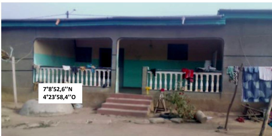
Fig. 12 : Habitation moderne à Gbonou
