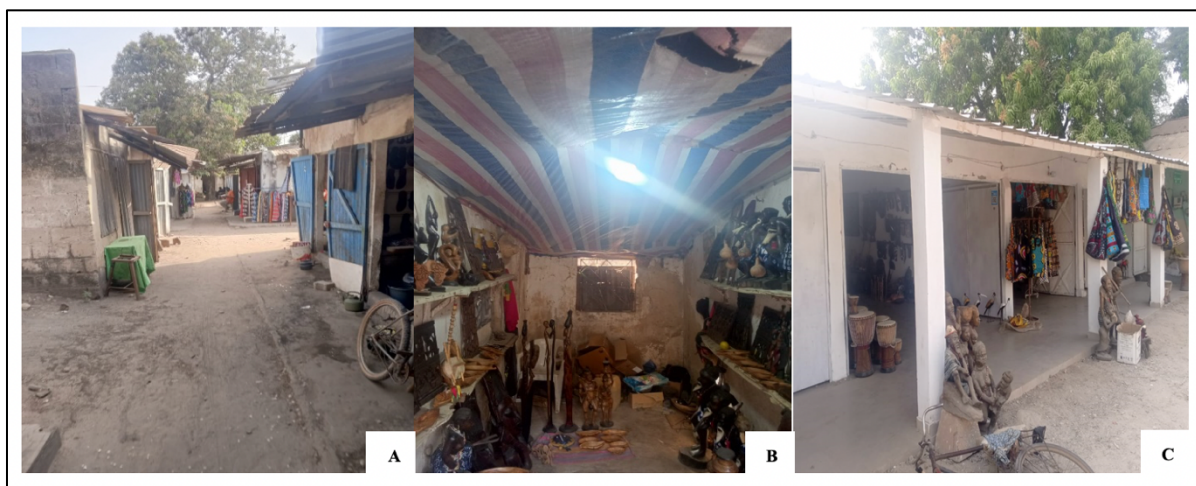
Fig. 7 : Étroitesse du marché (A), vétusté des bâtiments (B) et quelques magasins réhabilités.
