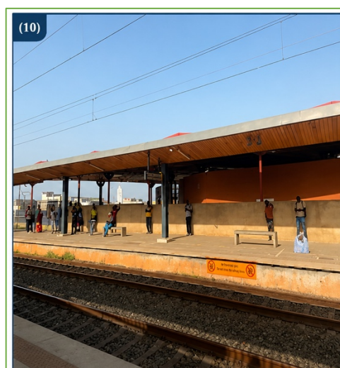
(10) Vue générale d'un quai de gare du TER.
