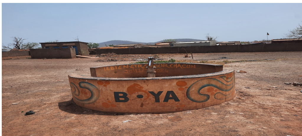
Fig. 4 : Forage construit par BOYA avec une pompe manuelle et en arrière-plan les deux toilettes
